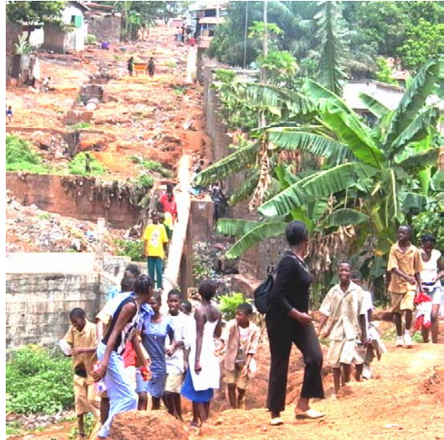
Traversée périlleuse d'un ravin entre deux quartiers sur un tuyau d'adduction d'eau, à Conakry
