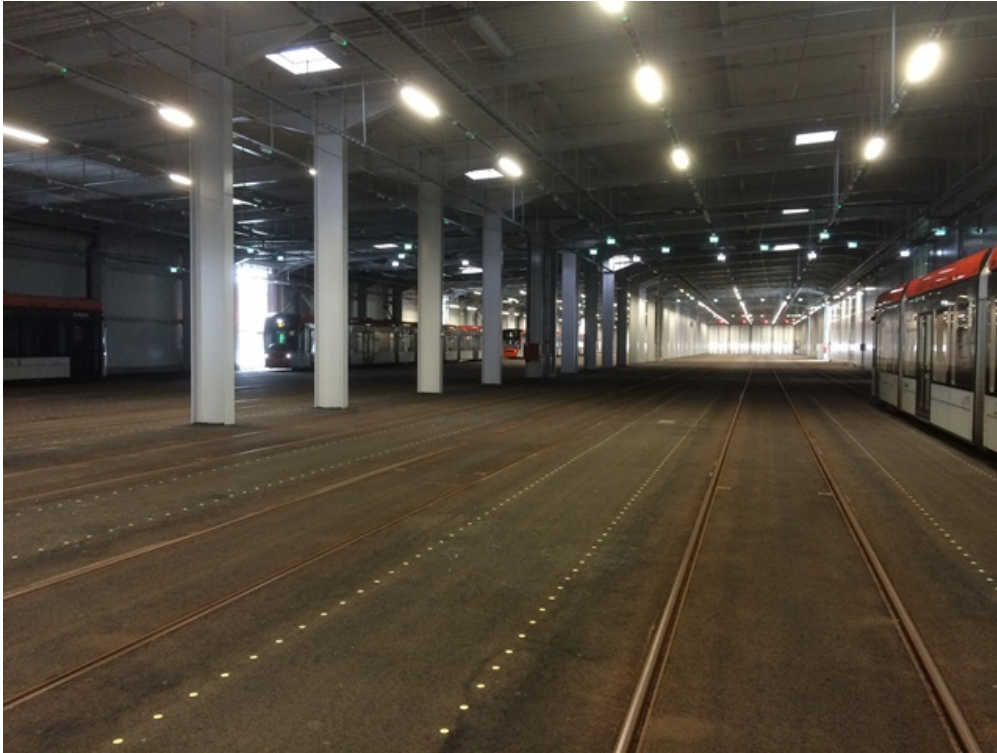
Dépôt de remise tramway couvert, Bergen
